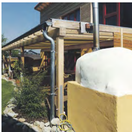
Pizzaofen und überdachte Terrasse erweitern den Wohnraum.
