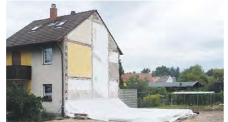
Neun Monate liegen zwischen dem Abriss und dem Einzug ins Holz-Lehm-Haus.
